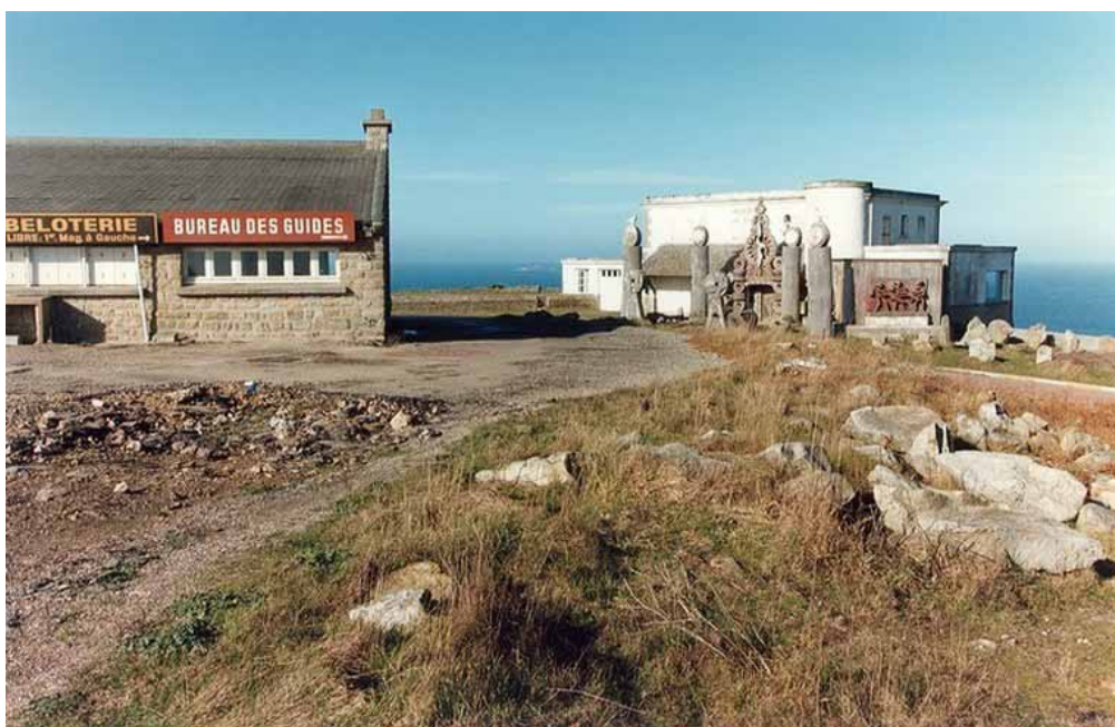
Avant travaux, les locaux d'accueil et de ventes de souvenirs
