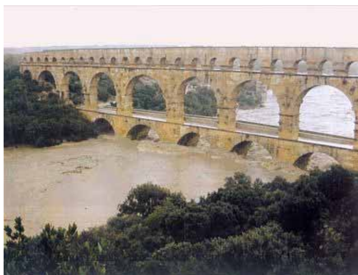
PONT DU GARD (CRUE 2002)
