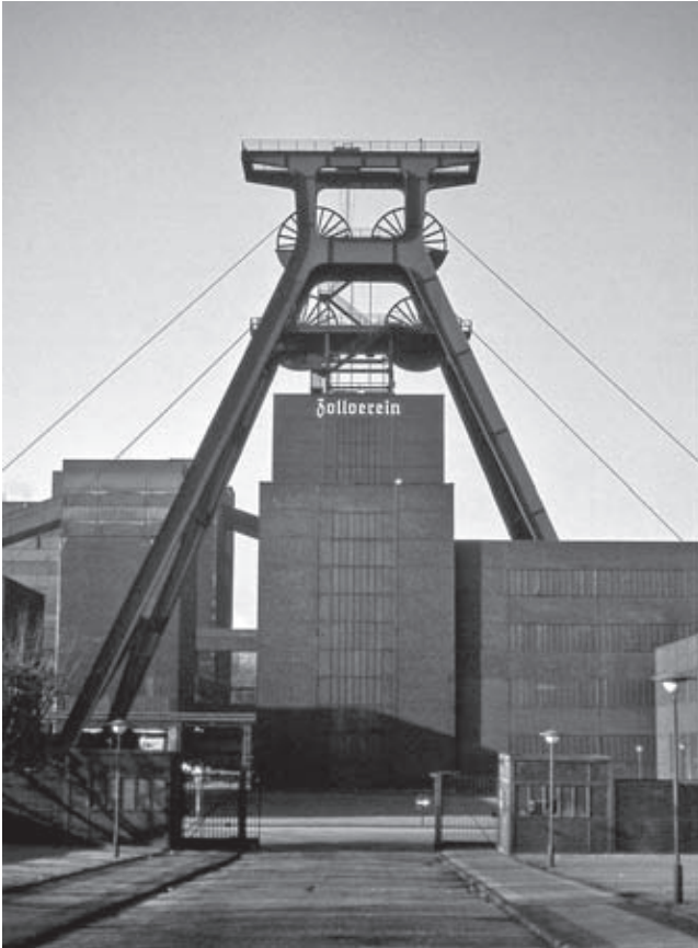
Zeche Zollverein in Essen, 1932, Arch. Schupp & Kremmer
