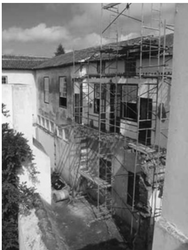
Dstrucción de galería y eliminación de patio del Colegio de los Jesuitas (después Universidad de San Fernando, hoy Real Sociedad Económica de Amigos del País (16-09-2004).
