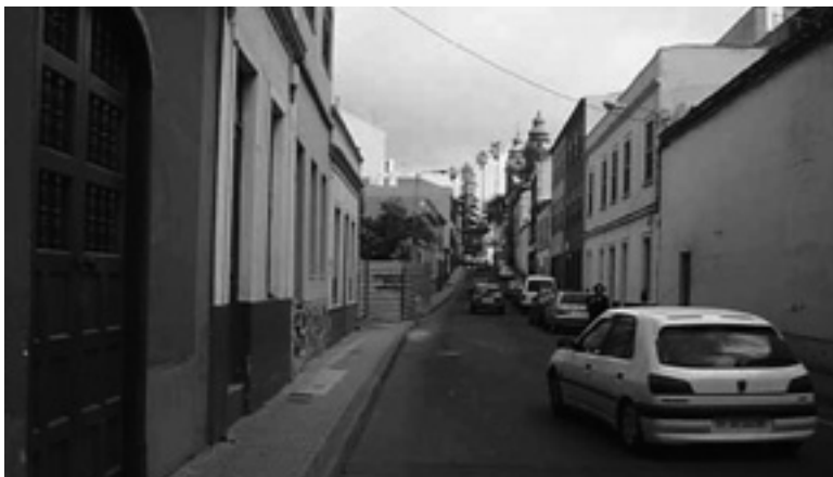
Calle de San Juan (10-03-2002), Antes de modificación de la manzana en el ámbito del Bien Cultural.
