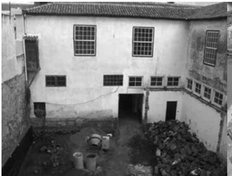
Dstrucción de galería y eliminación de patio del Colegio de los Jesuitas, después Universidad de San Fernando, hoy Real Sociedad Económica de Amigos del País (21-11-2004).
