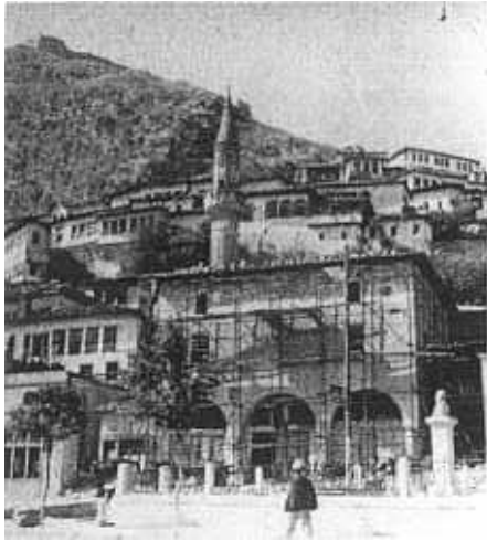
Fig. 11 - Berati. La moschea di Beqari (scapoli) durante i lavori di restauro preventivo.
