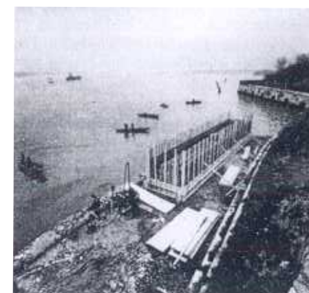
Fig. 2. - Venezia. Forte di S. Andrea. Esecuzione su cassone autoaffondante di uno dei settori dello scudo protettivo dall'erosione provocata dalle correnti d'acqua (1965).
