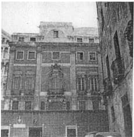
Fig. 4 - Cagliari. Zona di Castello. Il prospetto settecentesco dell'antico palazzo municipale.
