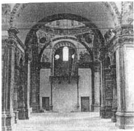
Fig. 5 - Brescia. Chiesa di S. Maria dei Miracoli, a restauro quasi ultimato.
