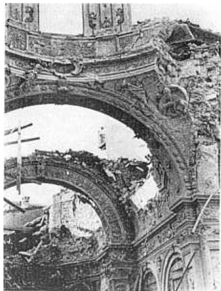
Fig. 2 - Brescia. Chiesa di S. Maria dei Miracoli dopo il bombardamento.
