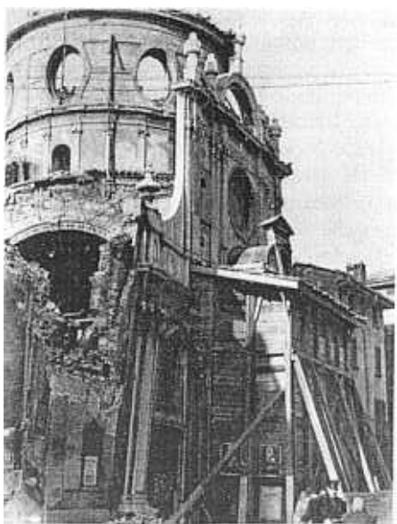
Fig. 1 - Brescia. Chiesa di S. Maria dei Miracoli dopo il bombardamento.
