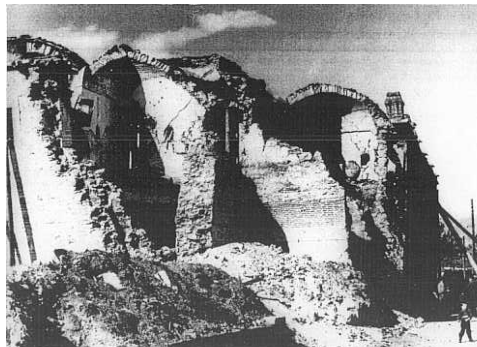
Fig. 2. - Skoplje. Les ruines du Kourchoumli-ban.
