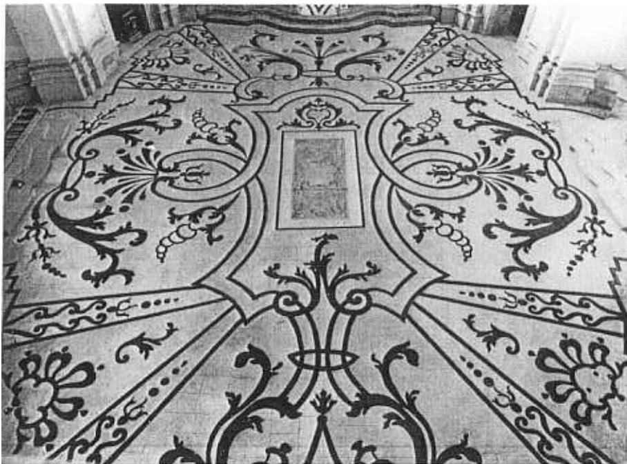
Fig. 6 - Siracusa. Chiesa di San Filippo Neri. Stato del pavimento restaurato.
