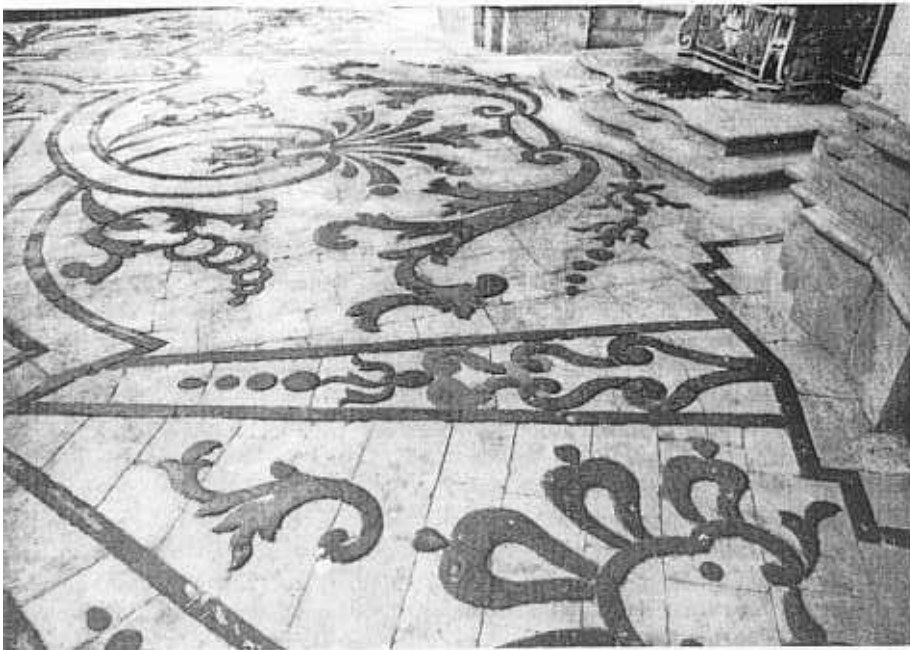
Fig. 2 - Parte destra del pavimento prima dei restauri.
