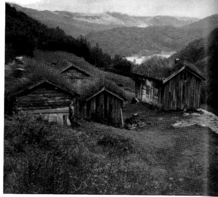
Kjellvik, Sørfold, Nordland. Remise en état de nombreux bâtiments délabrés grâce aux crédits débloqués par le Fond de l'Emploi en 1984-85.
