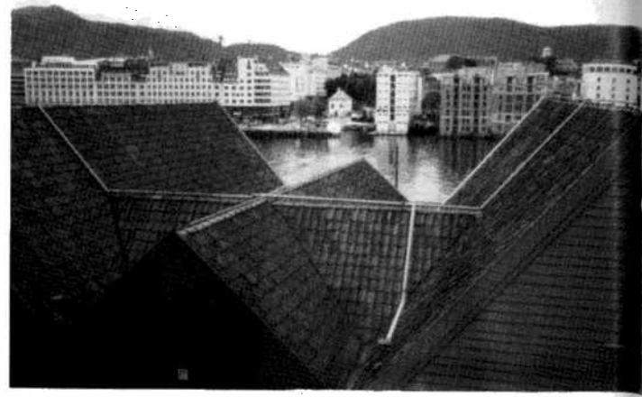
Toit de la partie reconstituée de l'hôtel avec pignon transversal rendu nécessaire par la salle occupant toute la longueur du premier étage.
