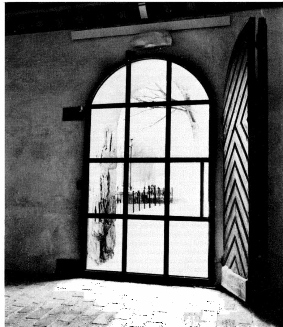
Additional day-light was admitted by putting a new glass door behind the old one in the southern porch. Photo: S. Rosengren. L'admission de la lumière du jour a été améliorée en plaçant une nouvelle porte vitrée derrière l'ancienne dans la porche. Der Tageslichteinlass wurde ergänzt durch den Einbau von einer neuen Glastür hinter der alten Tür im Paradies.
