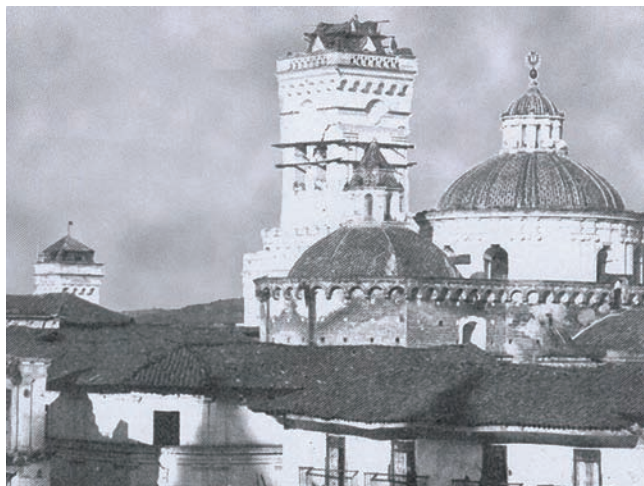
Reconstrucción de la Torre-Campanario de la Compañía de Jesús en Quito después del terremoto 1868
