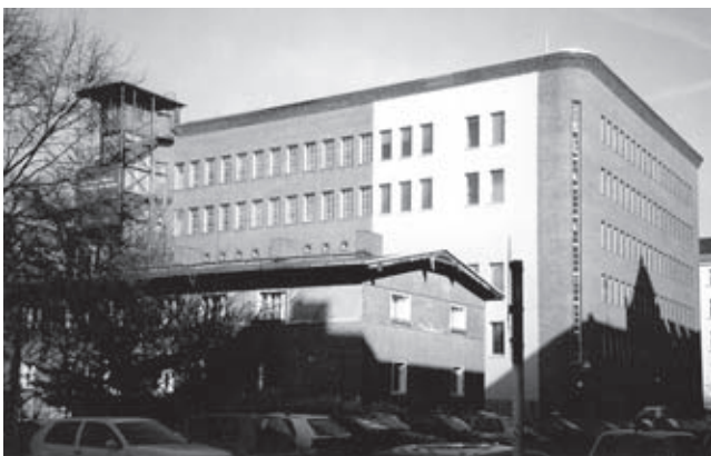
Трансформаторная станция на Лейбництрассе в Берлине после перестройки в дизайнцентр. Снимок 2004 г
