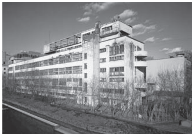
Дом-коммуна «Наркомфина», Новинский бульвар, 25, Москва, 1928–1930, арх. М. Я. Гинзбург, И. Ф. Милинис, инж. С. Л. Прохоров. 2005 г
