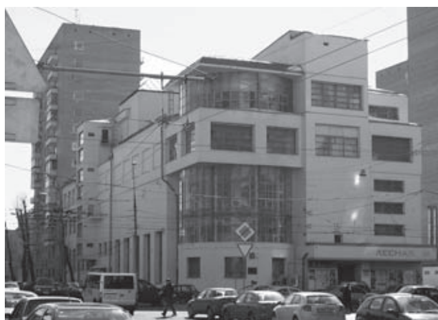
Рабочий клуб им. Зуева, ул. Лесная, 18, Москва, 1927–1929, арх. И. А. Голосов. Состояние 2005
