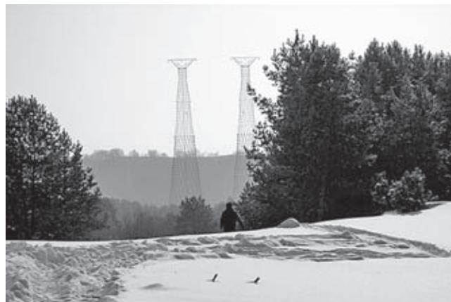
Пятисекционные опоры линии электро-передачи НИГРЭС (высота каждой башни 128 м) на берегу Оки около г. Дзержинска Нижегородской области, возведенные по проекту В. Г. Шухова в 1927 году
