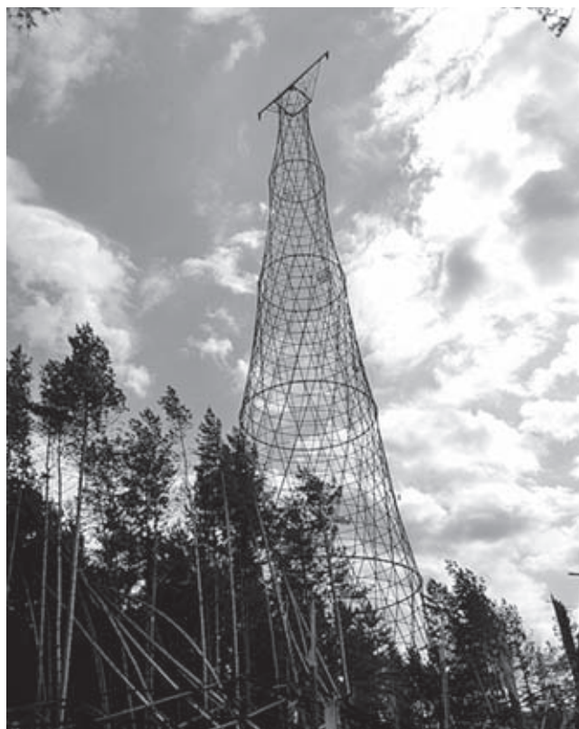
Сохранившаяся опора линии электропередачи НИГРЭС около г. Держинска. Фотоснимок апрель 2005 г
