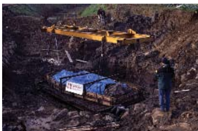
Figure 3: Una vez separado el bloque con el pecio, del lecho de fango fue necesaria una gran grúa para cargarla en un camión especial de altura regulable
