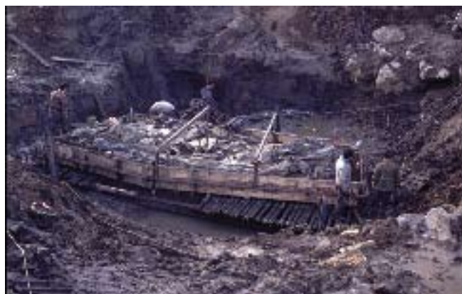
Figura 2: Para extraer el pecio en bloque, del fango del río fue necesario separarlo del lecho por medio de una pantalla horizontal de tubos que cortaba el terreno
