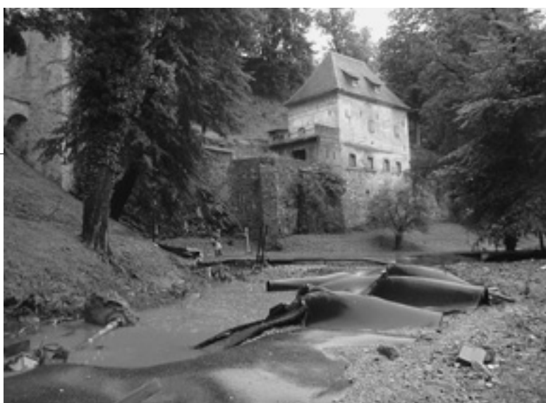
Český Krumlov, the brought down asphalt road in Jelenka
