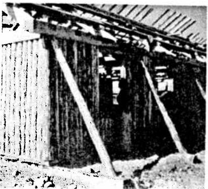
Fig. 11. Piquet house reconstruction as *pieux en terre* or *poteaux sur sol*.
