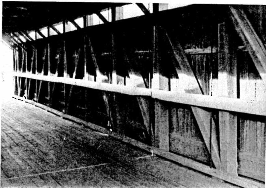
Fig. 2. Cette ferme à poinçons multiples, assez simple en soi, a été brevetée par le colonel William Howe (point Drouin à Compton Station).
