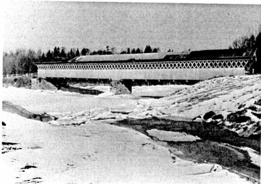
Fig. 1. Le pont Gould à Lingwick dans l'Estrie, sur la rivière au Saumon, avec sa dentelle, une structure brevetée par Ithiel Town en 1820. Il aurait été érigé en 1883.
