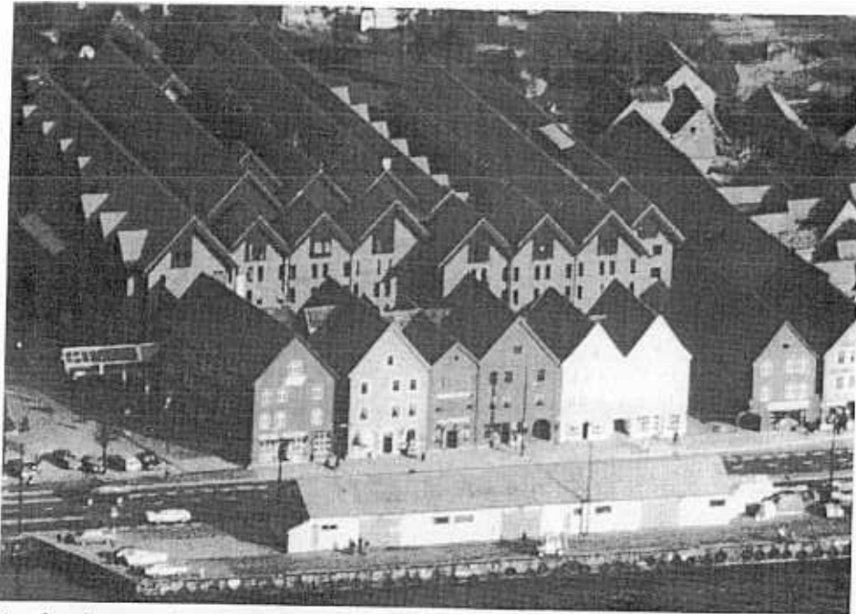
Les façades reconstituées en 1982 The front rebuilt in 1982
