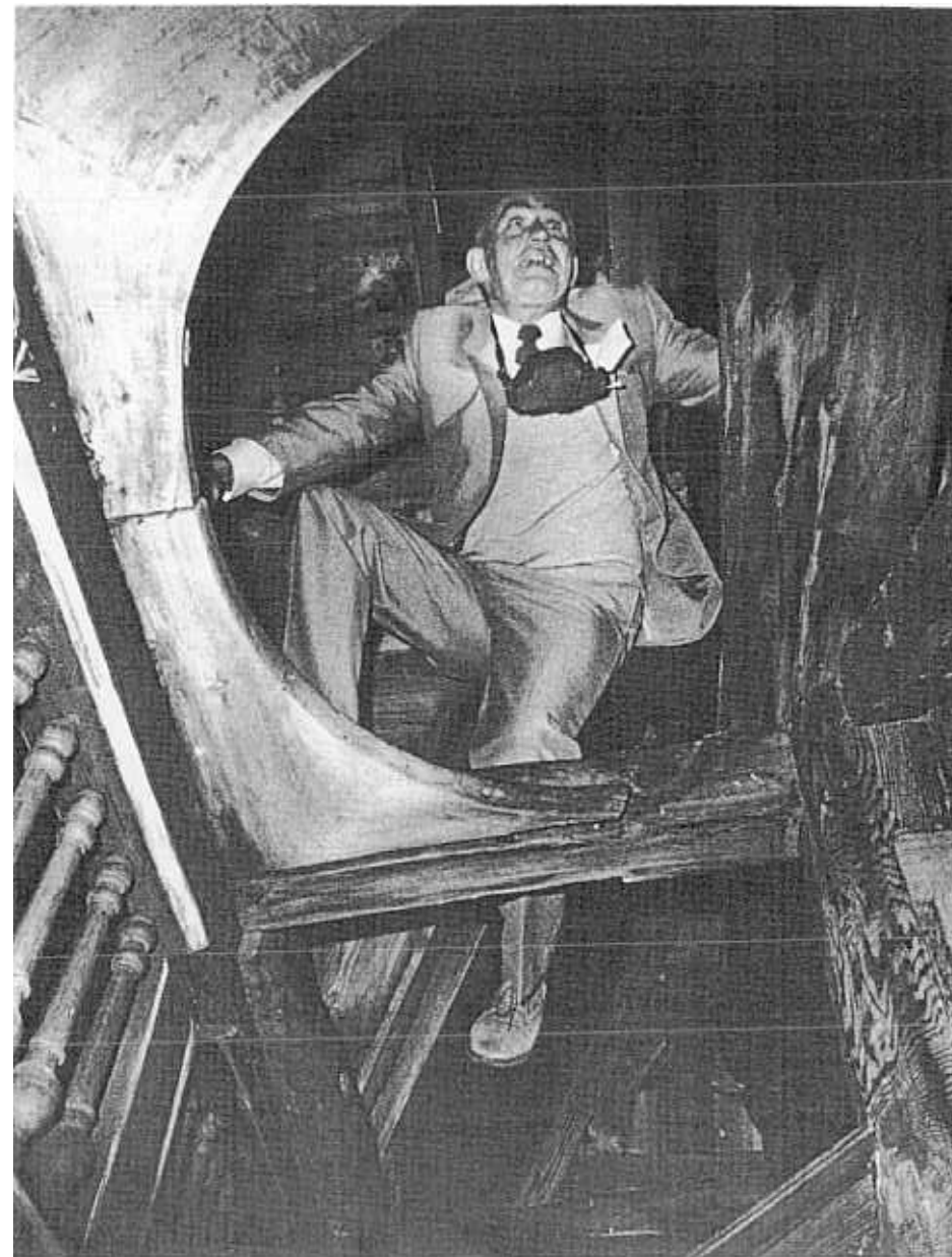
Mr. Longépé climbing to the roof. M. Longépé grim pant vers les combles. Photo Sverre Mo, Bergens Tidende 1983.
