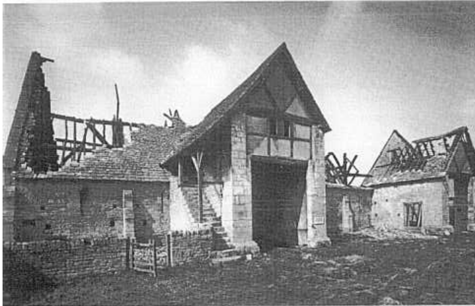
1. View from south-east a week after the fire Vue du sud-est une semaine après l'incendie
