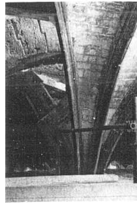
Fig. 14 - Rouen, Eglise St. Ouen. Portail des Marmousets, détail des travaux.
