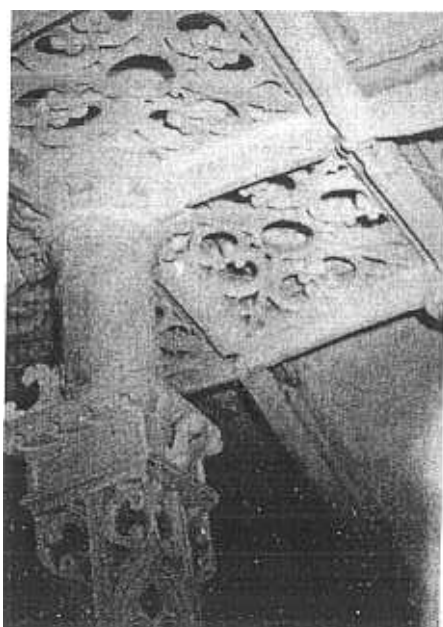
Fig. 9 - St. Jacques du Tréport. Type de clef avec un système de compartiments carrés, avant et pendant les travaux.
