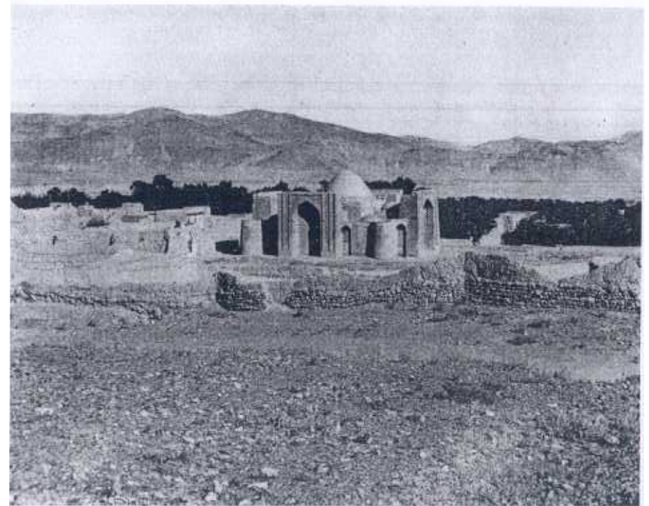
Fig. 10. - Afghanistan. Ghazni-Rauza. Il mausoleo di Abdur Razaq. Vista da nord-ovest, dopo restauri nel 1964.
