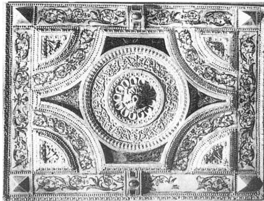
Fig. 3. - Mantova. Palazzo Ducale. Particolare degli stucchi recuperati della prima metà del secolo XVI. Un pannello dopo la pulitura e il restauro.
