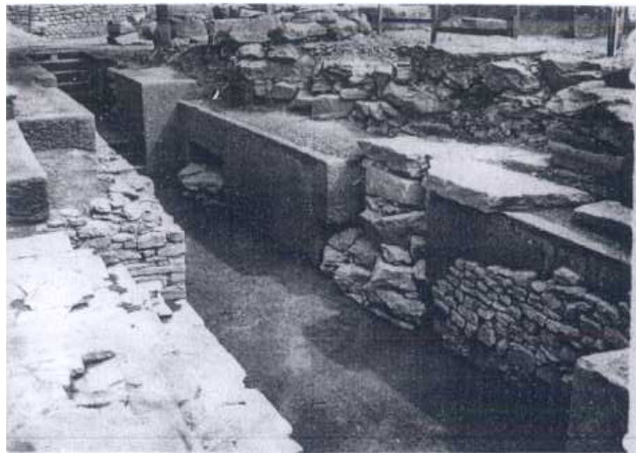
Fig. 10 - Fiesole. Due templi, uno costruito ex novo sopra l'altro; semidistrutto, del III secolo av. Cr. questo, del I av. Cr. l'altro. Il problema nasce sempre dalla precisione di scavo, che impone in conseguenza la soluzione del restauro conservativo reciproco dei due monumenti. Qui è rispettato il piano di accesso alla gradinata, che interrompeva il podio del tempio più antico (Restauro 1960-1961).
