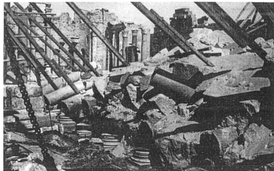
Fig. 5 - Leptis Magna. Appartenenza controllata delle colonne (granito rosa) alle loro basi (marmo bianco), in progressione esplorativa della stessa Basilica unitamente alla corrispondente trabeazione ed al corrispondente colonnato superiore.
