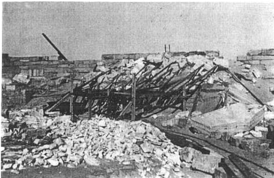
Fig. 3 - Leptis Magna. Mantenimento dello stato di crollo della facciata posteriore del tempio del Foro Nuovo Severiano in fase di scavo (1939).
