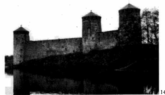
14. Olavinlinna restauroitiin vuosina 1961-1975 Esko Järventauksen suunnitelman mukaan. ■ 14. Olavinlinna church, restored by Esko Järventaus, 1961-75.
