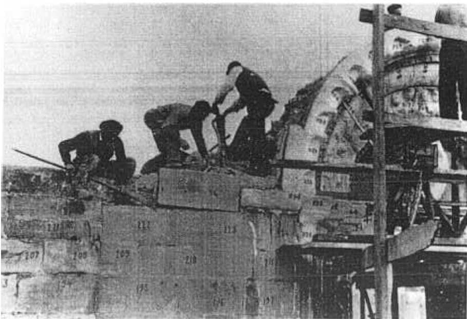
Fig. 3 - Puertomarin. Chiesa di San Juan, particolare dell'operazione di smontaggio.
