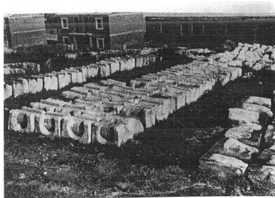
Fig. 4 - Puertomarin. L'allineamento dei blocchi smontati.
