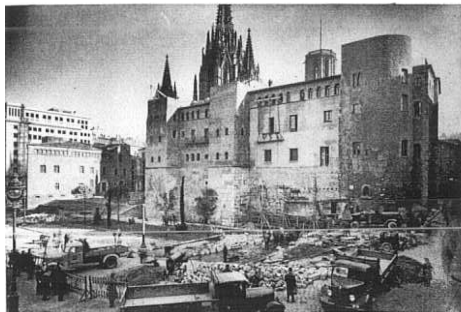
Fig. 8 - Barcelone. Les murailles de l'Avenue de la Cathédrale après que huit maisons qui les cachaient ont été démolies (23 janvier 1958).
