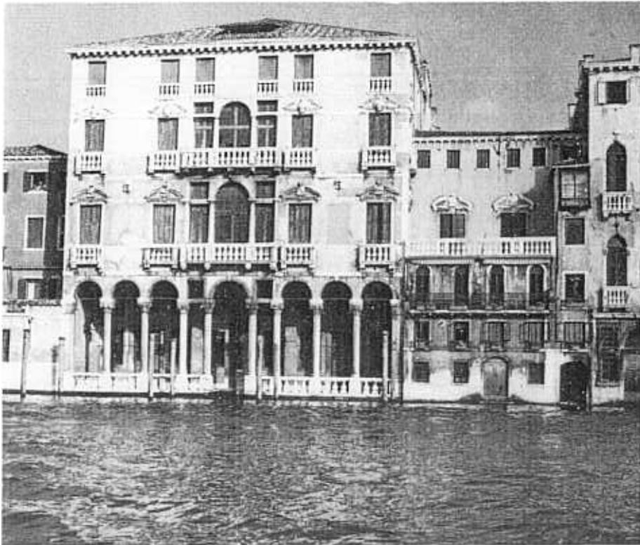
Fig. 3 - Venezia. Palazzo Michiel dalle Colonne, stato attuale.
