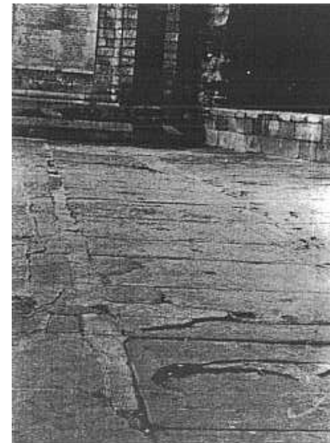
Fig. 13 et 14. - Aspects du canal souterrain qui passe à quelques mètres du portail. (Photographie Archives I.C.C.R., Madrid).
