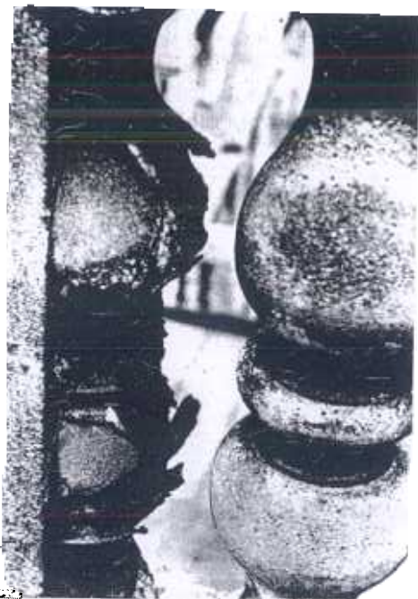
Fig 9. Vienne, Université. Détail d'une balustrade : les petits éléments atteints par la pluie sont intacts, les autres totalement abîmés (nouveau balustre à droite).
