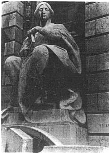
Fig 20. - Londres, Edmonton Arch, Navigation. Croûtes extérieures exclusivement localisées sur les zones abritées de la pluie.
