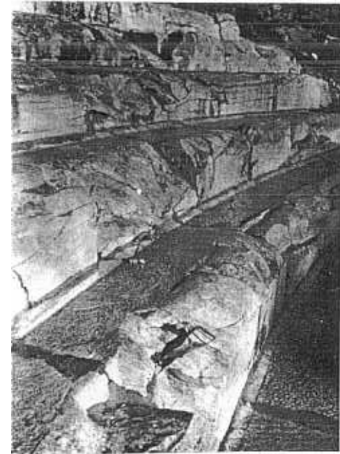
Fig. 29. Athènes, Odéon de Hérode Atticus. Arêtes des gradins arrondies par l'éclatement sous dilatation.
