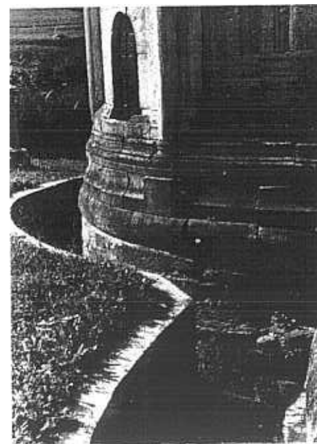
Fig. 10. Gurk. Fosse autour d'une église ancienne pour baisser le niveau de l'humidité.
