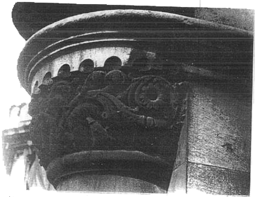
Fig. 15. - Londres, Tempel Gardens. Incrustations limitées aux motifs protégés de la pluie.
