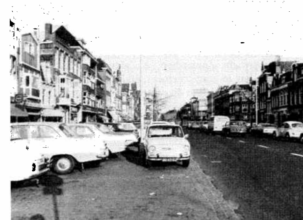
Fig. 14. — Photo de 1969. Le « Zuiderdiep » comblé avec 2 chemins, une route de circulation médiane en asphaltée avec, à gauche et à droite, des bandes de parking en pavés ; entre les jeunes arbres, de hauts réverbères.
