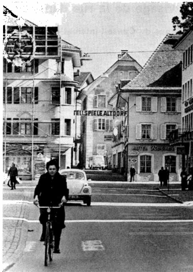
Même site en 1972 : bien des choses ont été altérées mais les volumes sont demeurés ; ils doivent être maintenus.
