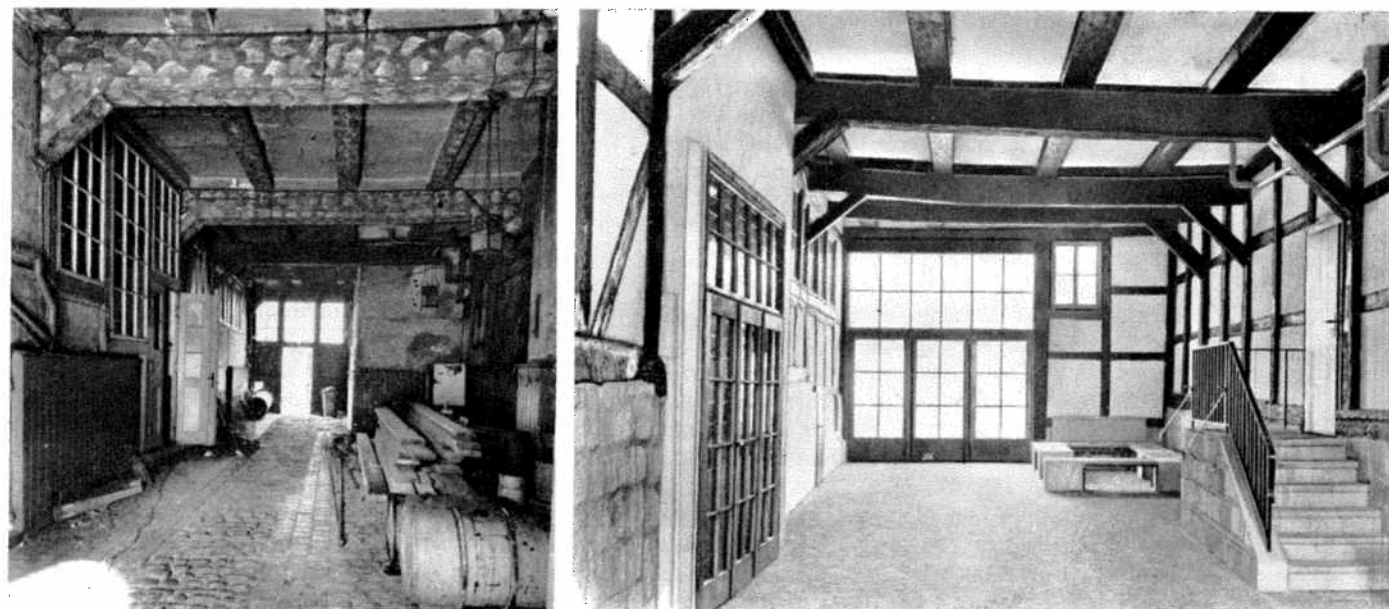
Entrée de la «Maison du soleil d'or» avant et après la restauration – The hall of the house "Zur Goldenen Sonne" before and after restoration and new installation
