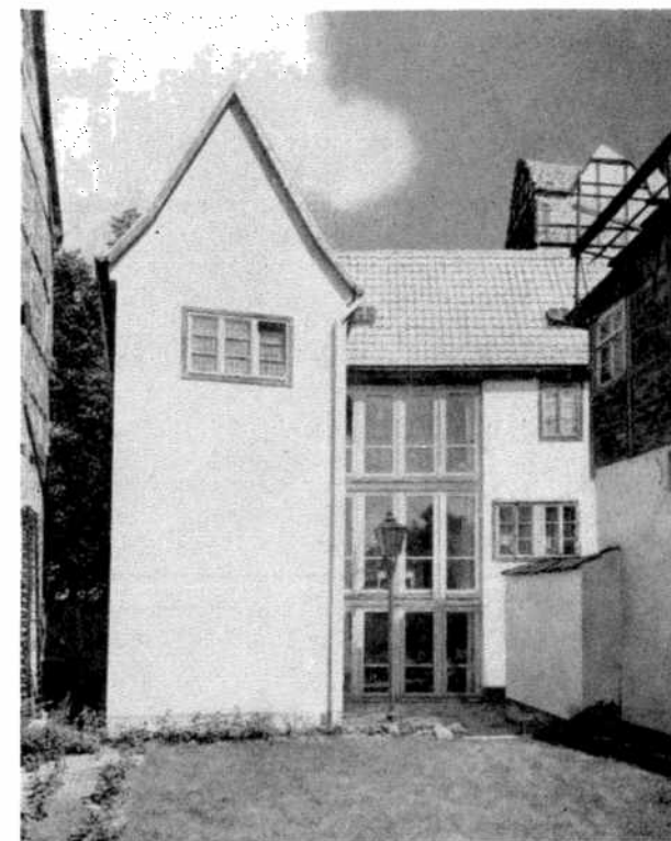
Nouvelle façade de la cour de la maison numéro 8 de la colline du château à Quedlinburg – New courtyard façade of the house Schloßberg 8 in Quedlinburg
