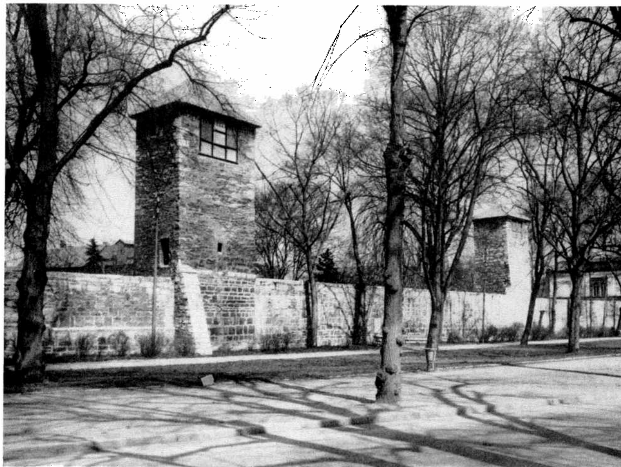
Partie restaurée du mur de défense – Restored section of the fortification wall
