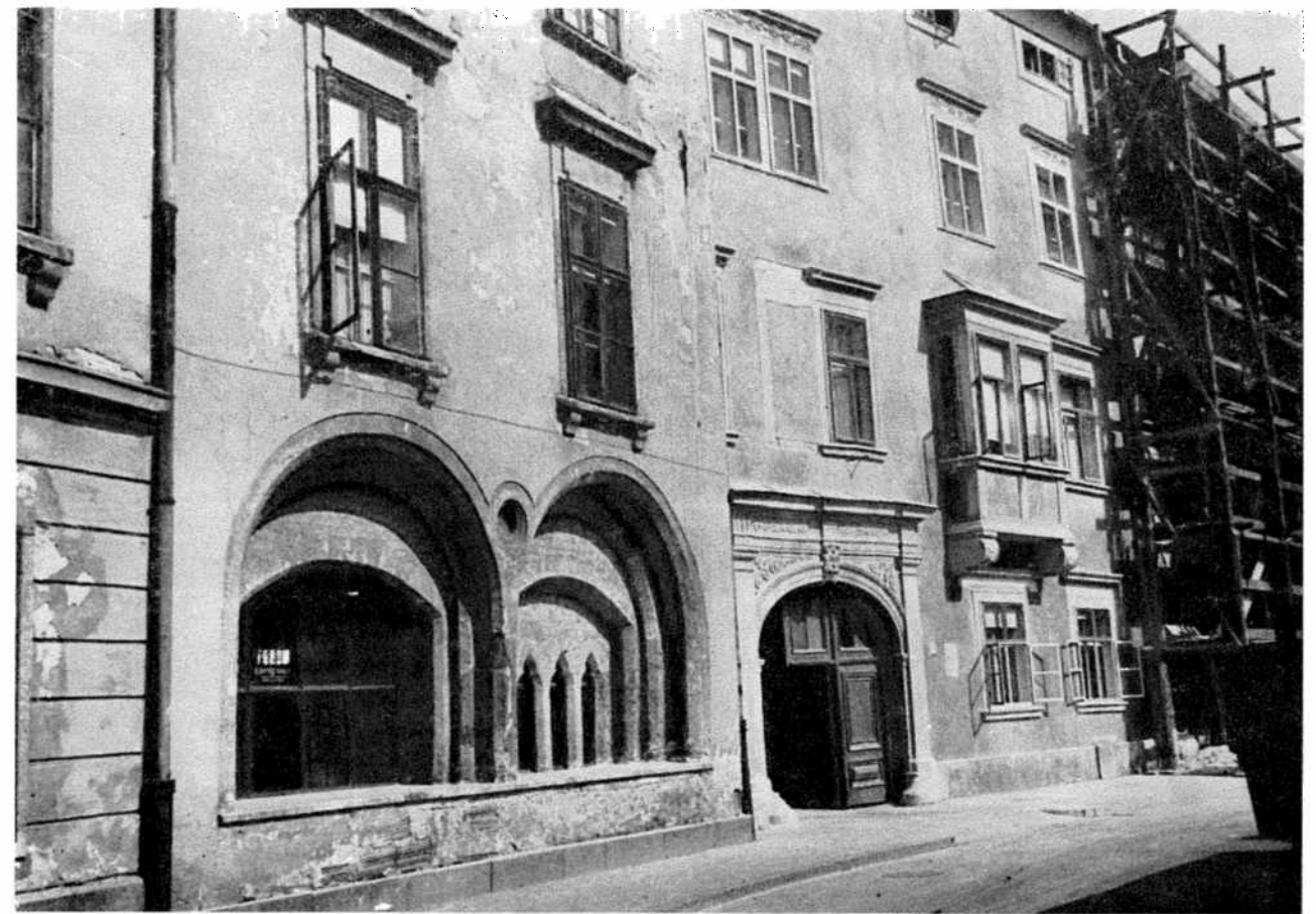
55. Sopron. Szt. György utca 1—3. Détail de la façade après restauration. (Architecte: Gy. Riedlmayer) 55. Sopron: 1-3, Szt. György Street. Detail of front after restoration. (Architect: Gy. Riedlmayer)
