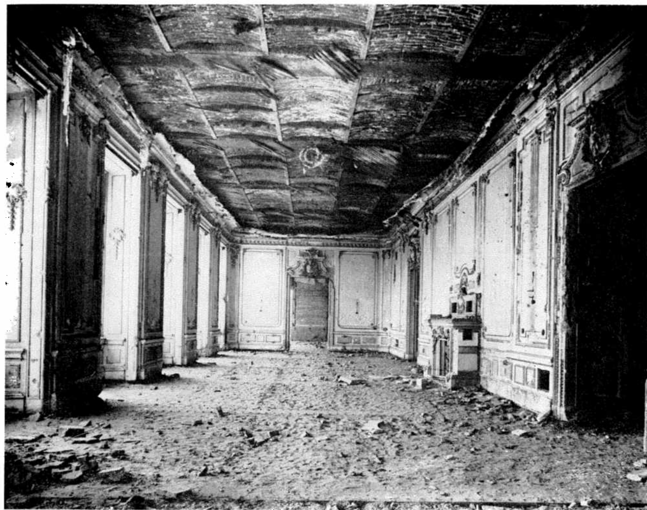
15. Budapest. Intérieur de l'ancien palais royal après la deuxième guerre mondiale 15. Budapest: Former Royal Palace. Detail of interior after the Second World War
