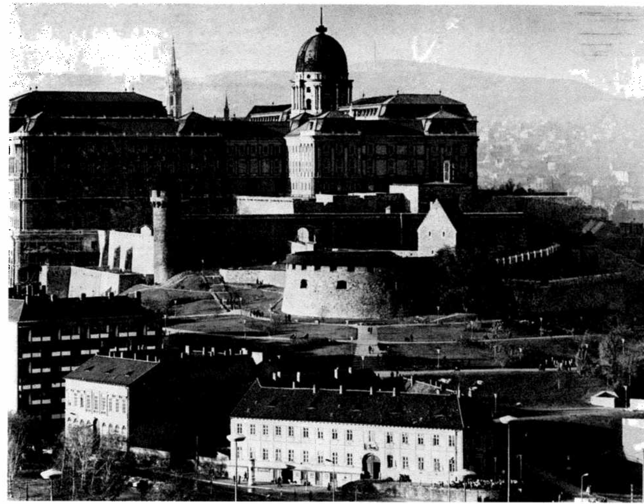
44. Budapest. Les fortifications du côté sud de l'ancien palais royal de Buda, après reconstruction. (Architecte: L. Gerő)
