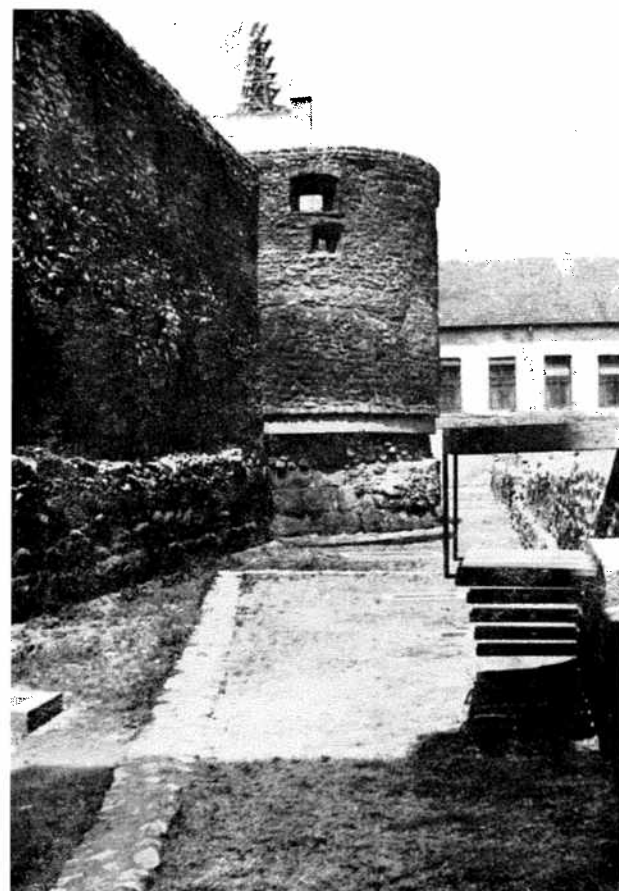
57. Sopron. Remparts du moyen âge. Un des bastions circulaires de la section est. (Architecte: Mme J. Nagypál-Kiss)
