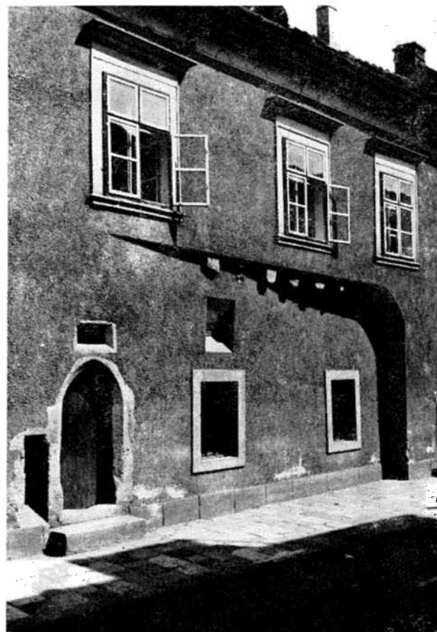
56. Sopron. Új utca 9. Détail de la façade après restauration. (Architecte: J. Sedlmayr)
