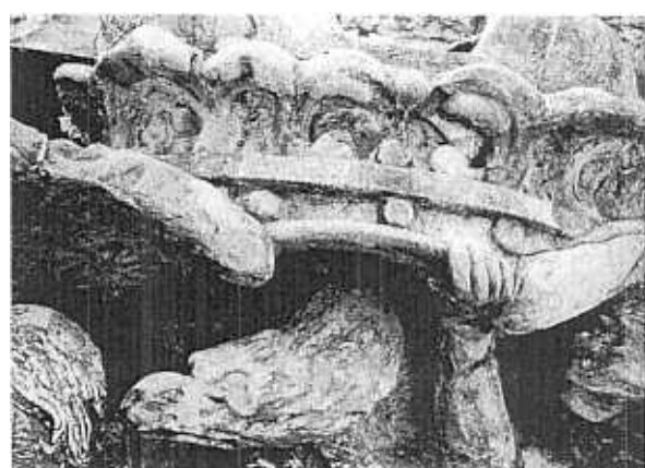
Fig. 5 d. — La Chapelle Royale à Gdańsk. Détail pendant la conservation. Complété plusieurs fois de mortiers.
