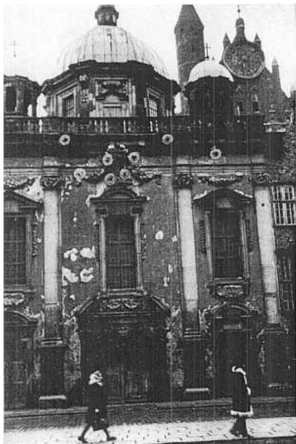
Fig. 5 a. — La Chapelle Royale à Gdańsk. Marque des prises d'échantillons.
