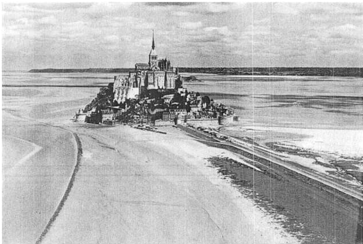
Fig. 6. — Le Mont Saint-Michel (France) dans son entier fait l'objet d'une zone de protection. Archives photographiques, Paris.
