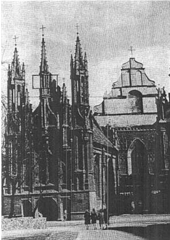
Fig. 12. — Ensembles des églises gothiques de Sainte-Anne (Onos) et des Bernardins (à droite), Vilnius. L'endroit de la substitution des colonnes en brique est marqué par le rectangle aussi bien que le démontage de la tourelle.
