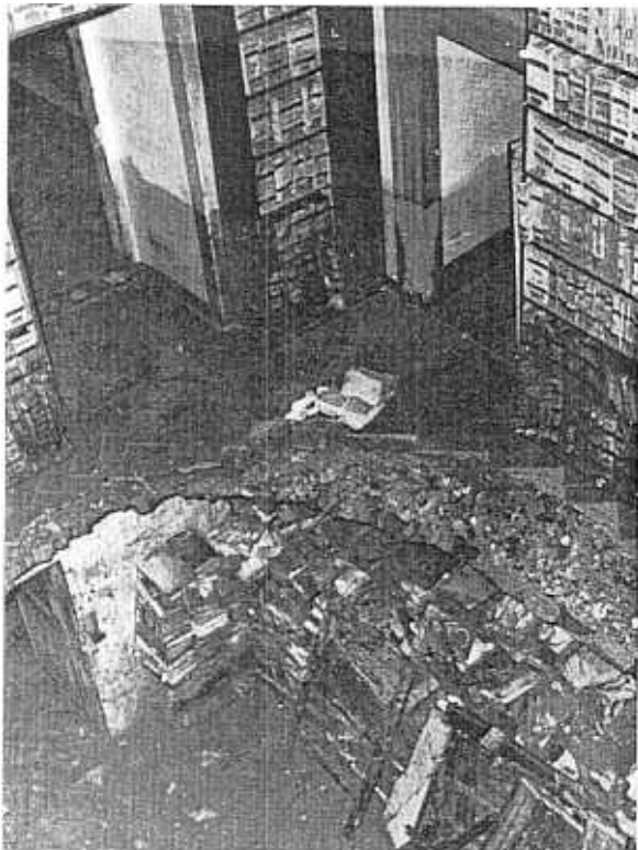
Fig. 4. — Tache d'humidité à la basilique Saint-Marc de Venise, après la haute marée de 1966.
