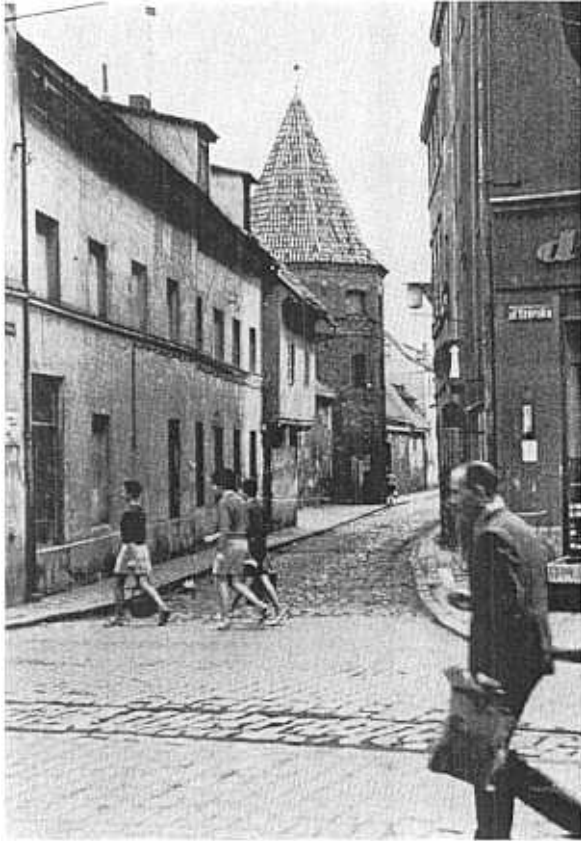
Fig. 10. — Rue Podmurna (Longeant-le-mur), avec une tour médiévale entourée de maisons du XIX e siècle.
