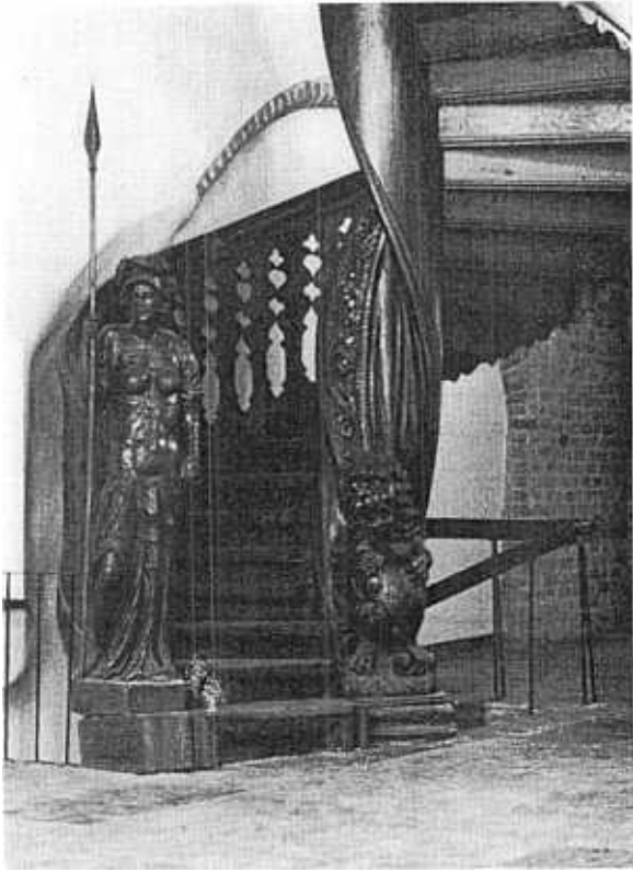
Fig. 23. — Même maison. Escalier de 1697 après les travaux de conservation à l'intérieur.
