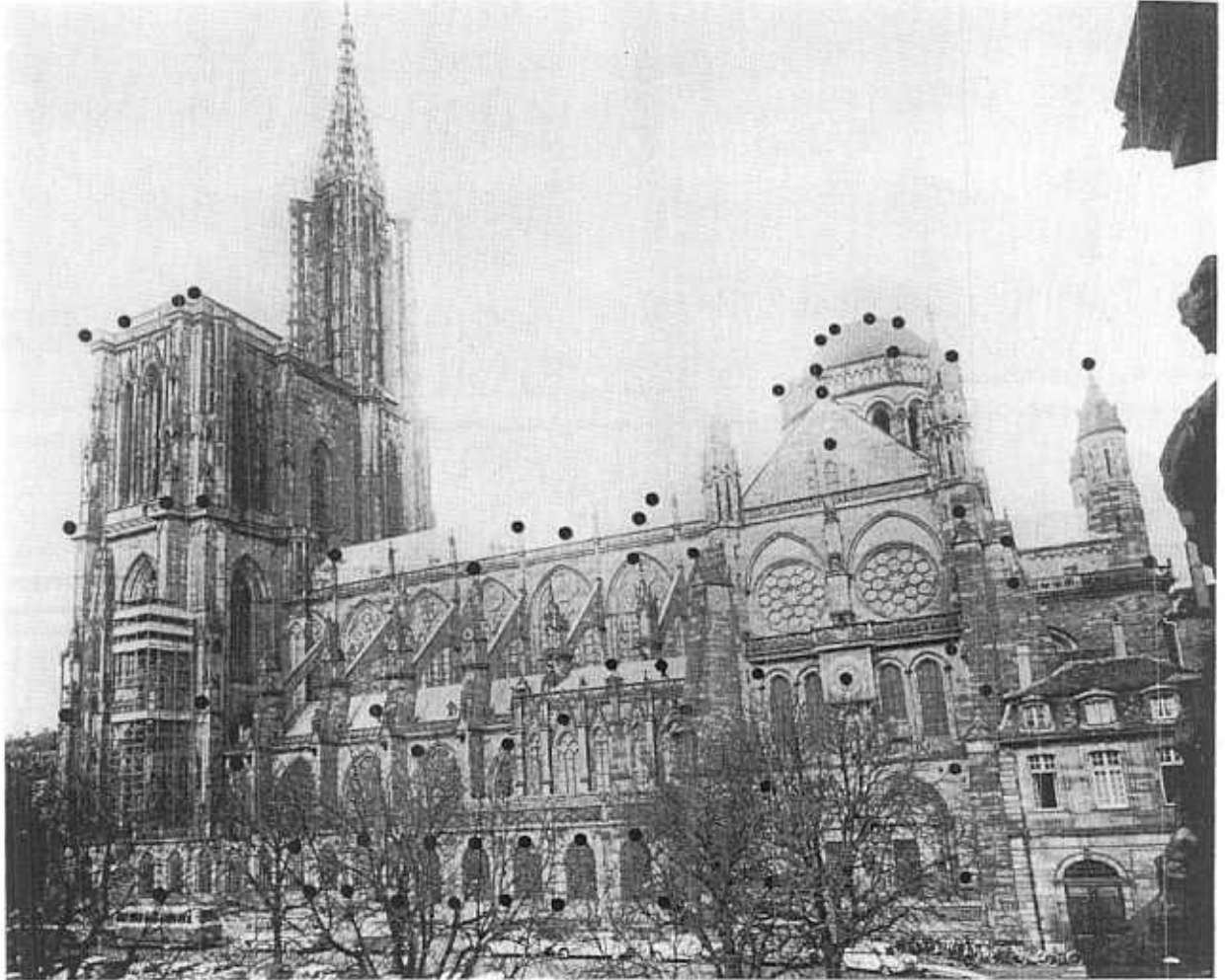
Fig. 24. — Relevé photogrammétrique de la face sud de la cathédrale de Strasbourg. A gauche, canevas des points de repère déterminés sur le monument dans un système de référence XYZ. A droite, schéma de la prise de vues. (Document IGN.)
