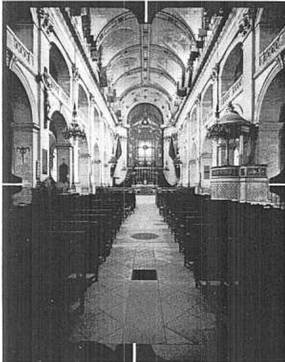
Fig. 2. — Exploitation directe d'une photographie métrique. Eglise Saint-Louis des Invalides, à Paris (chambre Zeiss T M K). A gauche, la photographie métrique, avec ses quatre repères, prise selon un axe rigoureusement horizontal et orienté parallèlement à l'axe de l'édifice. La connaissance de la distance principale de la chambre et celle des éloignements du point de
