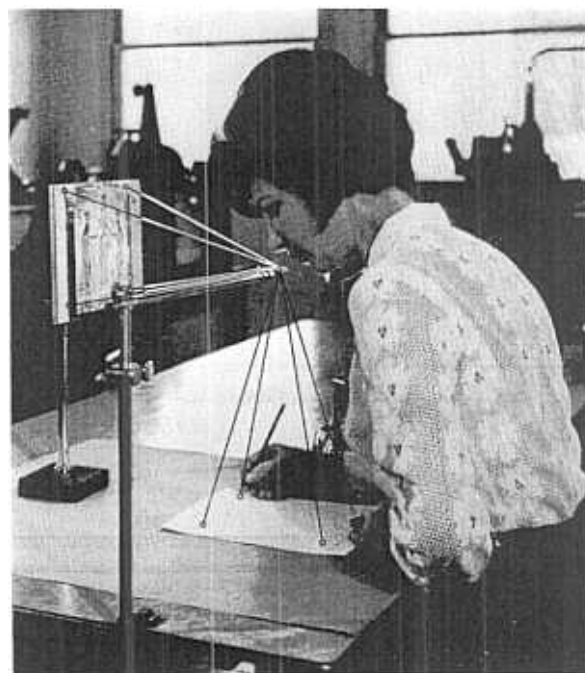
Fig. 5. — Redressement à la chambre claire. (Cliché IGN.)
