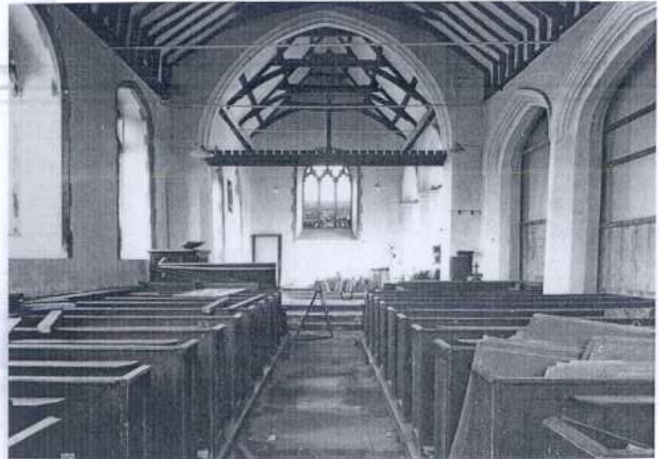
FIG. 3. St James, intérieure de l'ouest, avant travaux.
