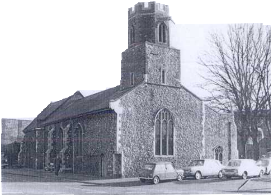
FIG. 2. St James, côté nord-ouest; corps du bâtiment; 15ème siècle murs de silex (typique du East Anglia); haut de tour en brique, 1743.
