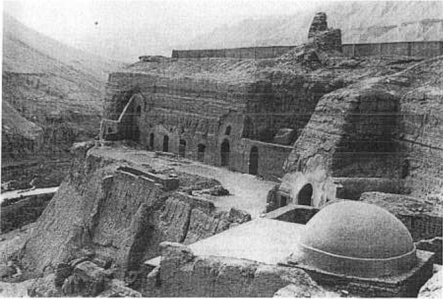
9. Bézéklík. La terrasse aux grottes. Restauration en cours. A l'avant-plan, reconstruction de la coupole sanctuaire.
