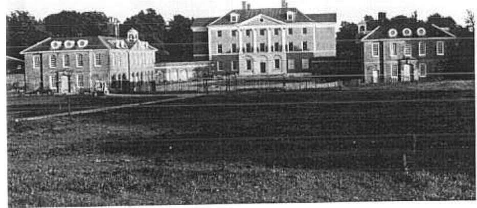
FIG. 7. Chevening; côté nord après la restauration de l'unité de l'ensemble par la démolition de l'étage supérieur et la reconstruction d'un toit en pente.
