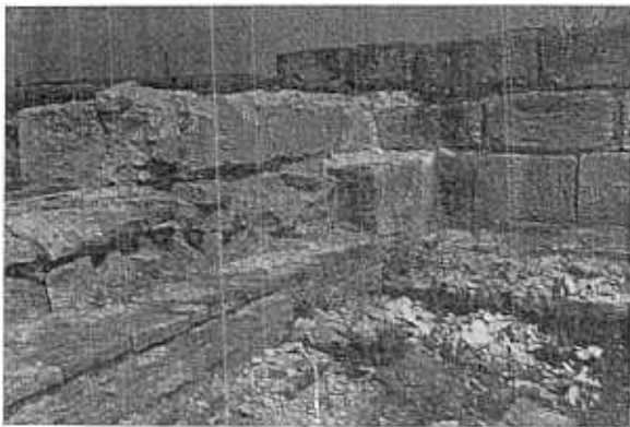
Une partie du mur nord après déblaiement détail
