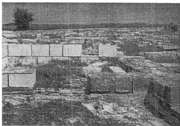
7. Restauration de la maçonnerie de pierres, détail. A droite — vestiges de la maçonnerie authentique
