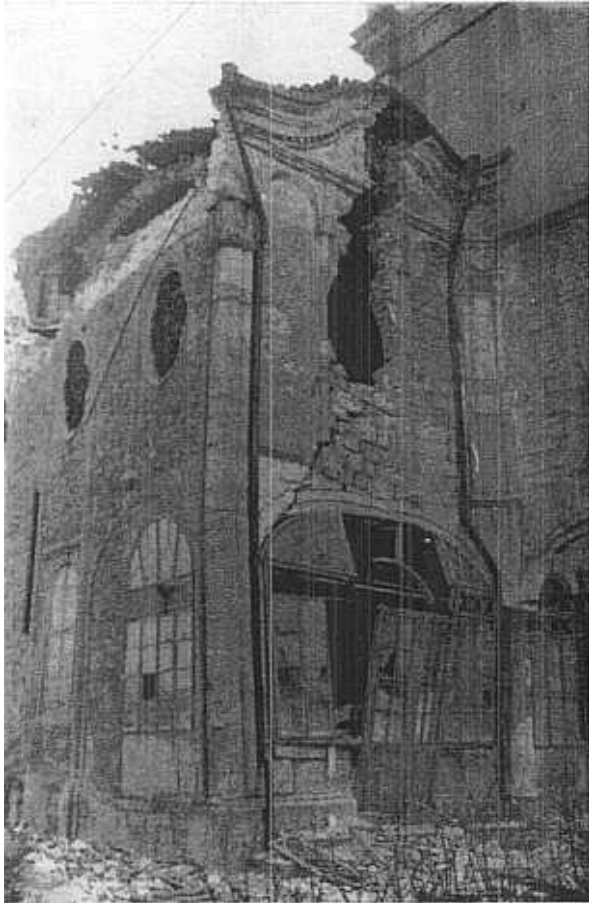
2. L'église après le séisme: à gauche — angle nord-est, à droite le clocher déséquilibré
