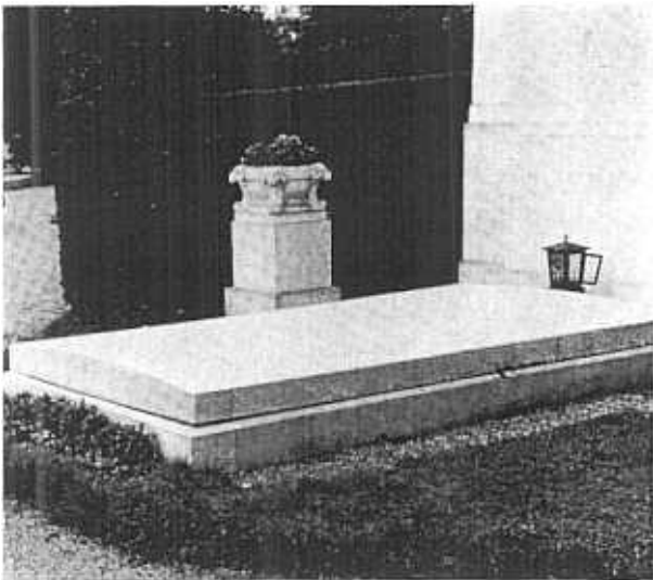
Fig. 41. — Vienne, Hietsinger Friedhof. Couverture d'un caveau courbé de quelques centimètres par relaxation des tensions internes.
