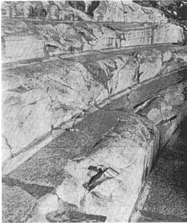
Fig. 29. — Athènes, Odéon de Hérode Atticus. Arêtes des gradins arrondies par l'éclatement sous dilatation.
