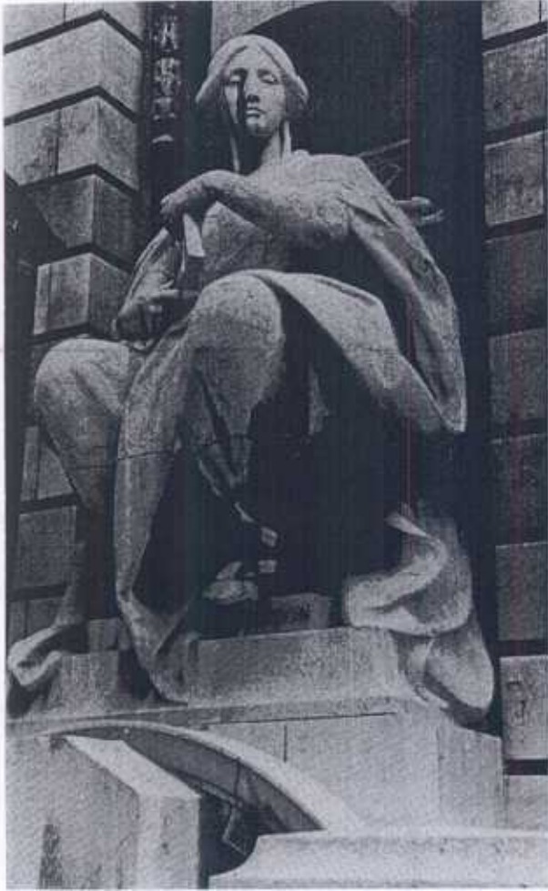
Fig. 20. — Londres, Edmonton Arch, Navigation. Croûtes extérieures exclusivement localisées sur les zones abritées de la pluie.
