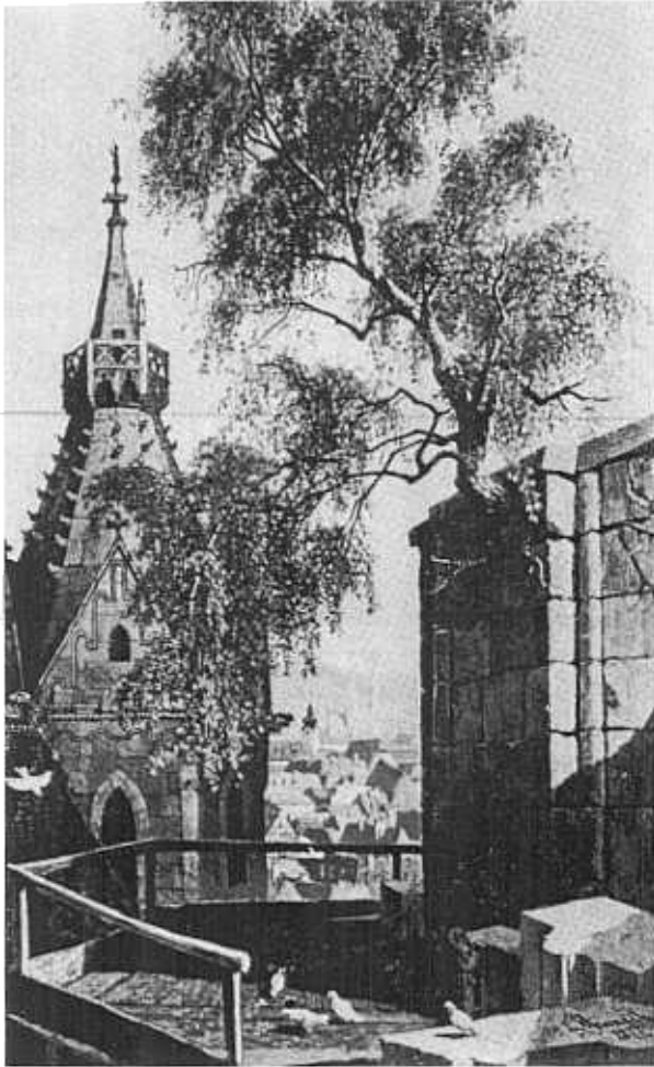
Fig. 32. — Vienne, St-Etienne. Bouleau dislocant les joints.
