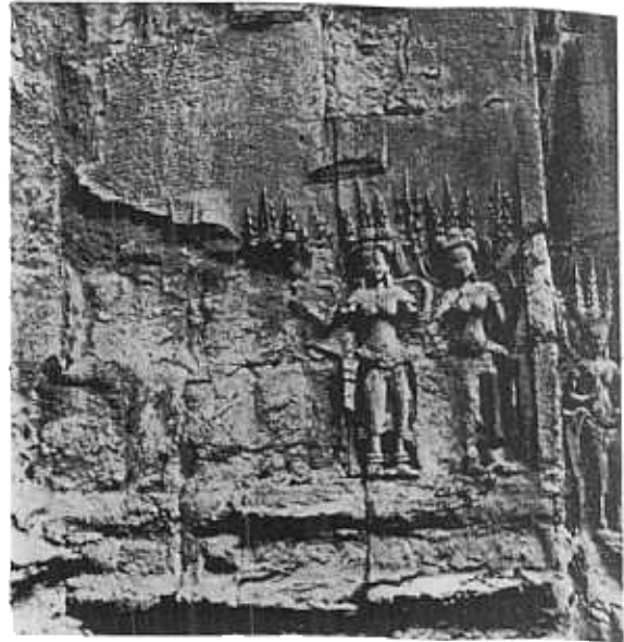
Fig. 17. — ANGKOR VAT (Cambodge). Deuxième enceinte, façade occidentale de la tour d'angle N.-E. Grès gris. Lésion en plaque très évoluée. (Cl. Lebon - Nguyen van Anh in Th. J. Delvert).
