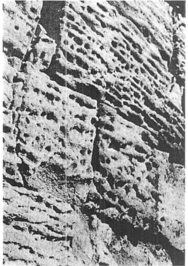
Fig. 2. — ARLES (B.-du-Rh.). Enceinte gallo-romaine. Molasse du miocène supérieur. Erosion en strie avec ébauche de géodes. (Cl. M.H. 155-680).
