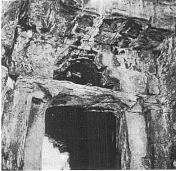
Fig. 16. — VAT PHNOM KROM (Cambodge). Grès gris. Délitage profond. (Cl. Ch. Meyer in Th. J. Delvert).
