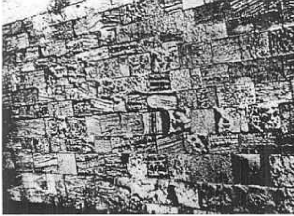
Fig. 4. — LANGRUNE (Calvados). Eglise, façade sud. Bathonien inférieur (pierre de Caen). Alvéolisation suivant le lit de la pierre. (Cl. M.H. 155-822).
