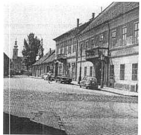
3. - Lors de la reconstruction totale du quartier d'Óbuda, des ensembles d'anciennes maisons ont été gardés sur plusieurs points pour conserver l'ambiance de la ville historique. La restauration des ensembles anciens (environ 30 maisons) aura lieu dans les années qui viennent.
